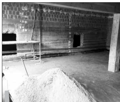
Ruszyła rozbudowa przedszkola w Przegini Duchownej. Foto: Daniel Mamala
